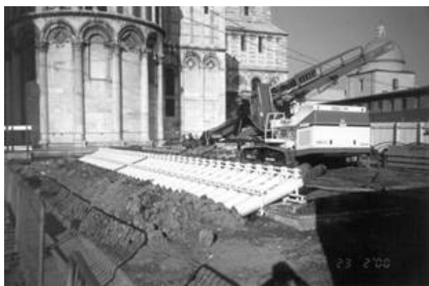
圖 7：鑽具和 41 個抽土管
