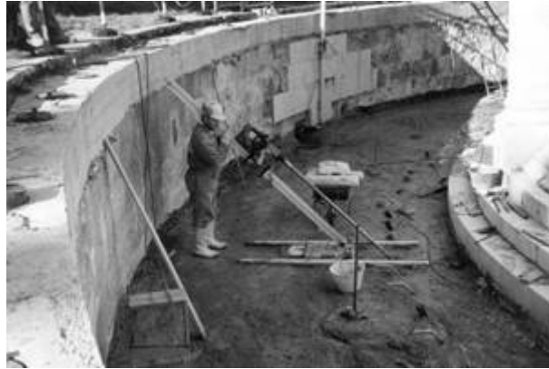
圖 9：走道鑽孔插入加強鋼棒緊系磚石地基和老的混凝土環
